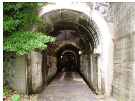
回天運搬用トンネル(筆者撮影。レールが除去され、セメントで埋められた跡が見える)
